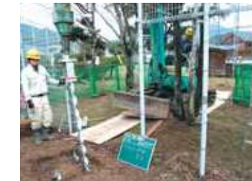
▲スパイラル杭施工状況
