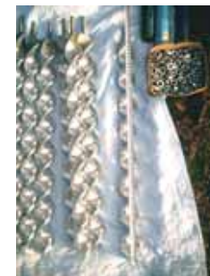
▲スパイラル杭 呼径φ50×9×600頭部ボルト溶接 32本使用
