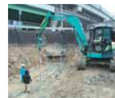
▲スパイラル杭打設状況
