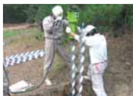
▲エアー杭打ち機による打設状況
