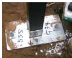
▲デッキ柱との接続部分
