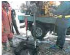
▲スパイラル杭打設状況
