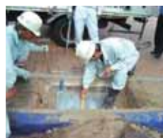
▲レベル確認(台座設置後)
