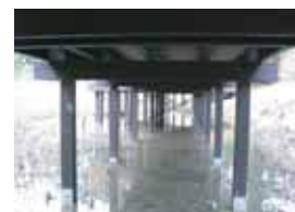
▲デッキ支柱部(完工後)
