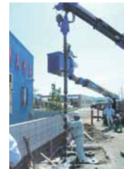
▲建駐車による杭打設
