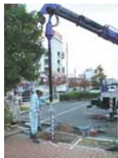
▲建柱車による打設状況
