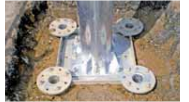
▲写-4.6 支柱建込み後連結ボルト本締め
