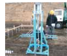
▲スパイラル杭打設状況（電動打設機）
