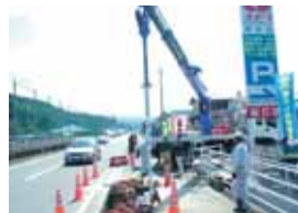
▲スパイラル杭施工状況
