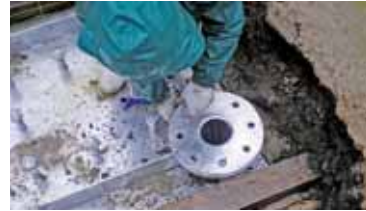
▲写-4.5 連結ボルト仮締め
