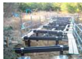
▲デッキ支柱部
