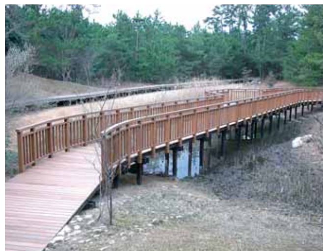
▲完成後デッキ全景
