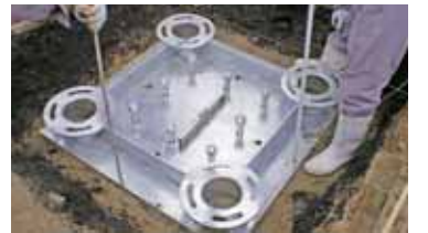
▲写-4.2 台座設置(位置調整)
