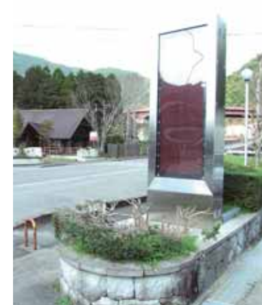
▲縦型サイン基礎 竣工
