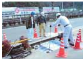
▲台座プレートの設置
