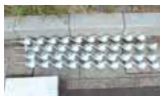
▲設置に使用したスパイラル杭
